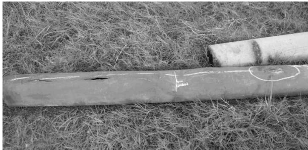
Gambar. 9. Foto Benda Uji Tube Mixed Feed yang Rusak
