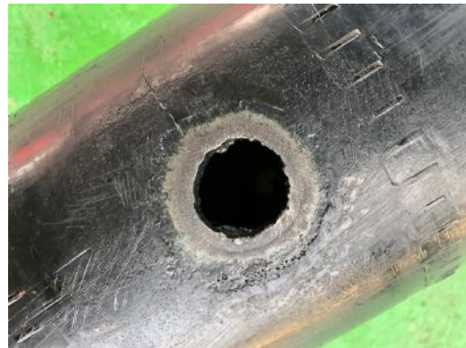
Gambar 4. Simulasi lubang kebocoran pada Manifold Hydrostatic Test
