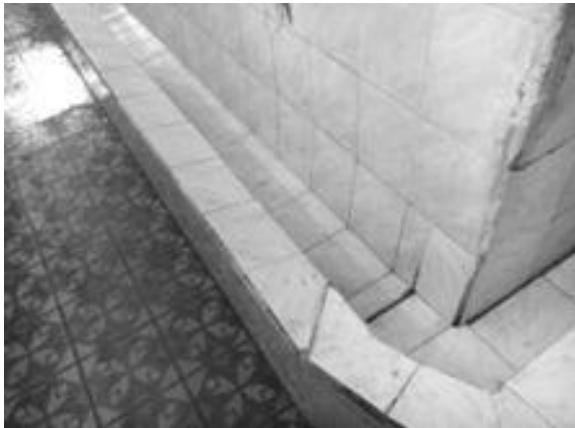
Gambar 5. Saluran dan Penahan Air Pada Tempat Wudhu di Masjid Raya At Taqwa Sumber : Peneliti, 2014
